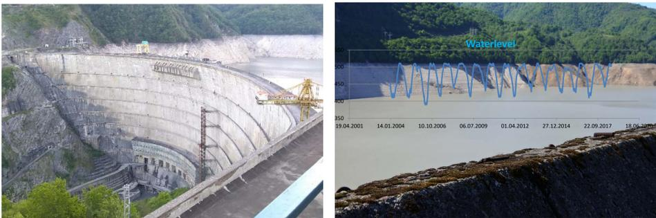
*Das Kraftwerk der Enguri Stauanlage versorgt mit 1.3 GW Leistung fast 50% von Georgien mit Strom. Der Damm besitzt eine Höhe von 277 m. Die jährlichen Wasserspiegelschwankungen betragen ca. 100 m.*
